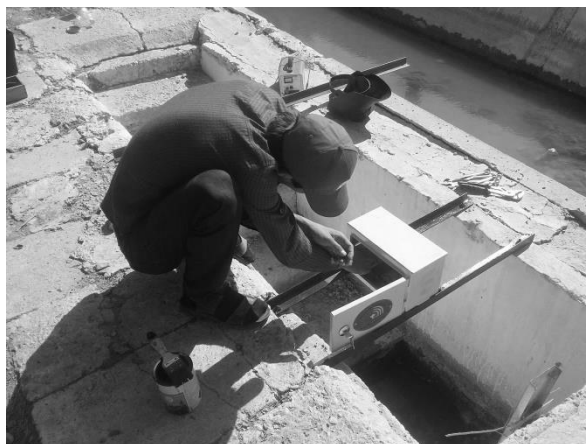
Рисунок 2. Монтажные работы по установке прибора ДУВ 2/0,005-10 на поверхности успокоительного колодца
