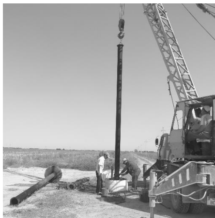
Рисунок 1. Демонтаж насосного оборудования
