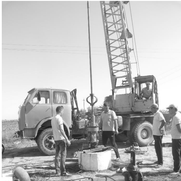
Рисунок 3. Монтаж насосной установки в скважину
