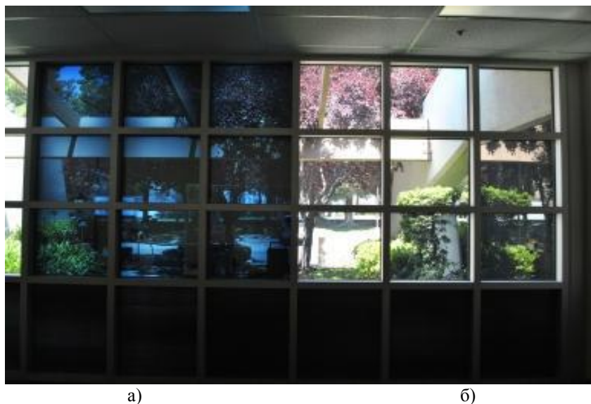
Рис. 2. Внешний вид фотохромных стекол: а) непрозрачное (при ярком освещении); б) прозрачное (при неярком освещении)
