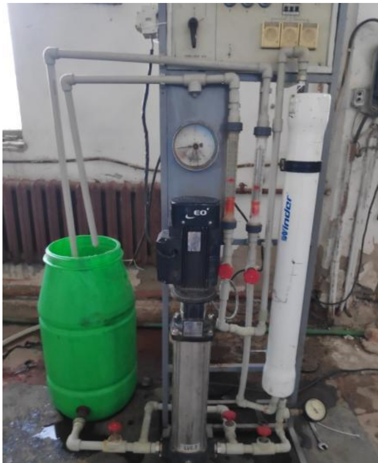
Рис. 1. Лабораторные испытания опреснительной обратноосмотической установки с аппаратами ESPA 1-400
