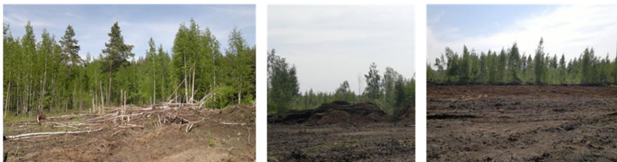
Снятие растительного покрова, сработка и складирование торфяной почвы
