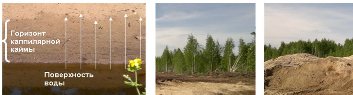
Снятие и сработка части слоя минеральных отложений до горизонта капиллярной каймы и их складирование
